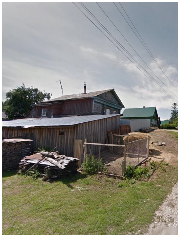
Ил. 11. Нижегородская обл., г. Городец, ул. Щорса, д.11. 2015 г. Вид с северо-востока. Точка фотофиксации 1.
