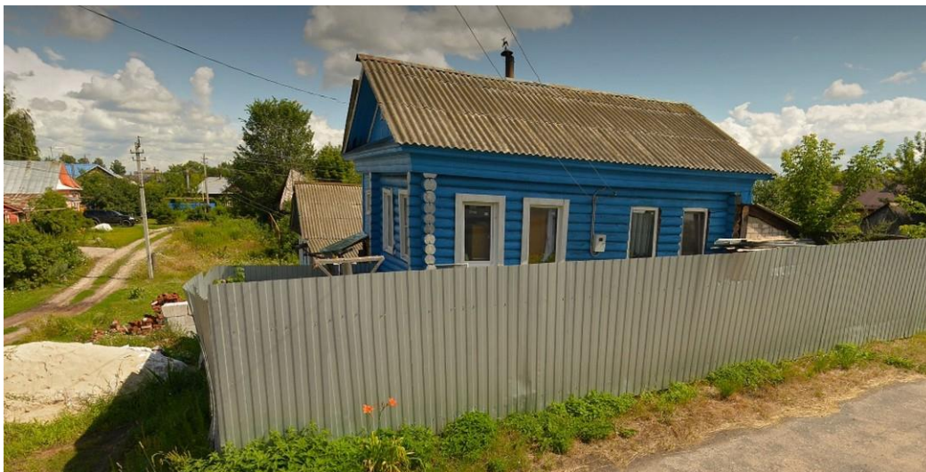
Ил.16. Нижегородская обл., г. Городец, ул. Щорса, д.11. 2022 г. Вид с запада. Точка фотофиксации 4.
