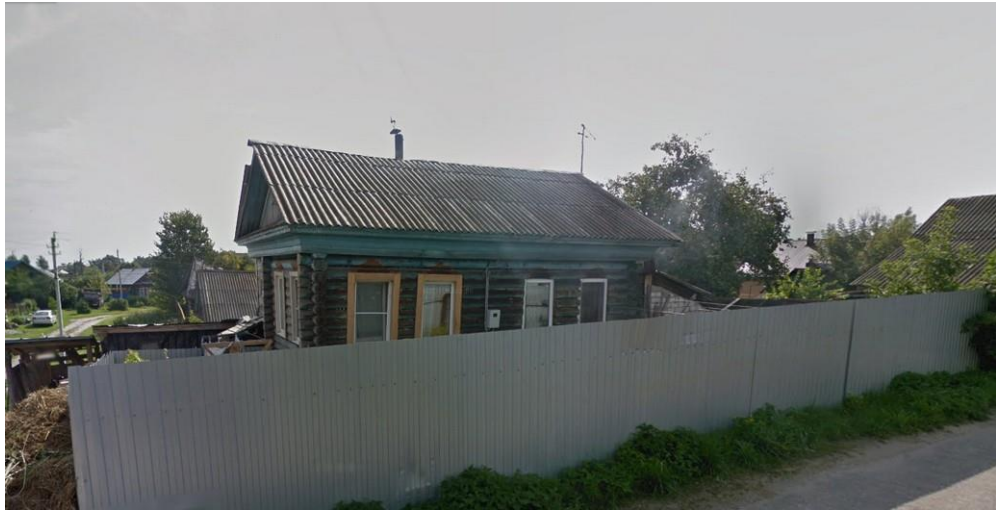
Ил. 14. Нижегородская обл., г. Городец, ул. Щорса, д.11. 2015 г. Вид с запада. Точка фотофиксации 4.
